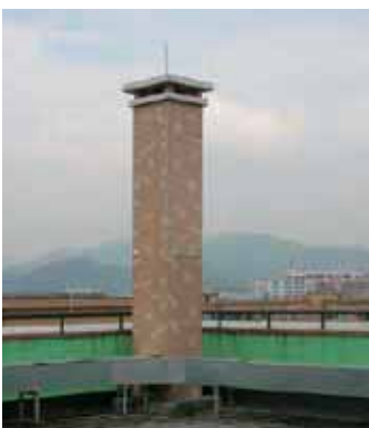
Schornstein zur Tarnung bestehender Antennenstandorte
