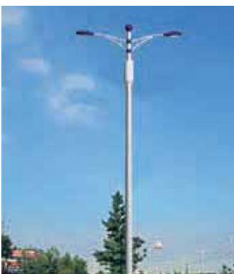
Lichtmasten mit eingebauter Makro- antenne
