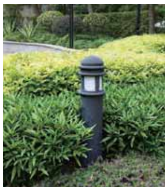
Wegeleuchten mit integrierter kleiner Antenne
